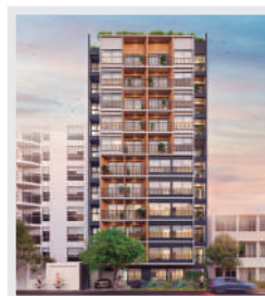
PORTA 360 MIRAFLORES EN CONSTRUCCIÓN
