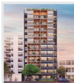
PORTA 360 MIRAFLORES EN CONSTRUCCIÓN
